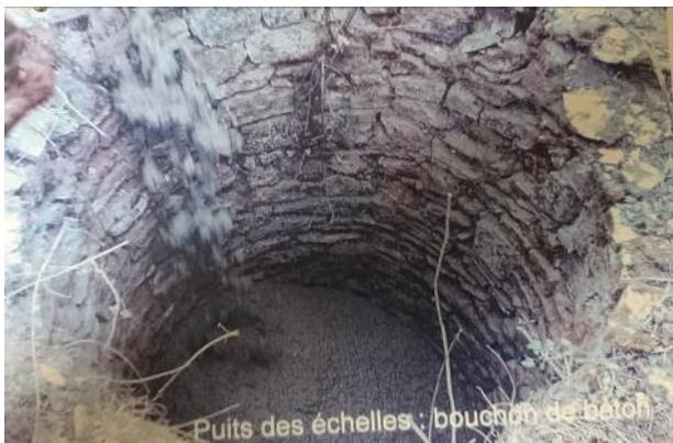
**Photo 17 : Puits des échelles pendant son bétonnage**
