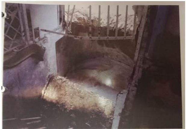
**Photo 16 : Tête du puits incliné pendant son bétonnage**
