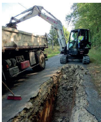
Terrassement route des Arcs
