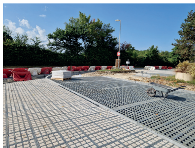
Travaux Place du cimetière
