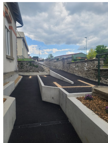
Accès à la mairie
