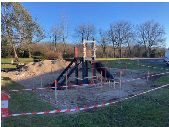
Réalisation de l'implantation
