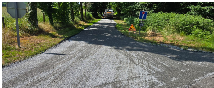
Reprofilage route de Lavaud
