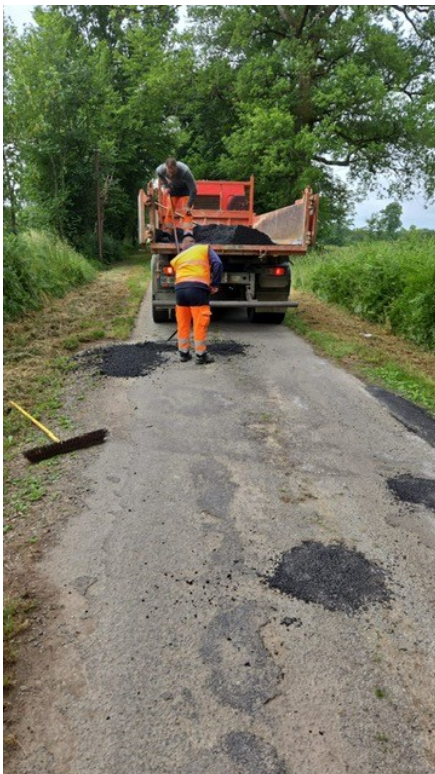
Préparation route de Lavaud
