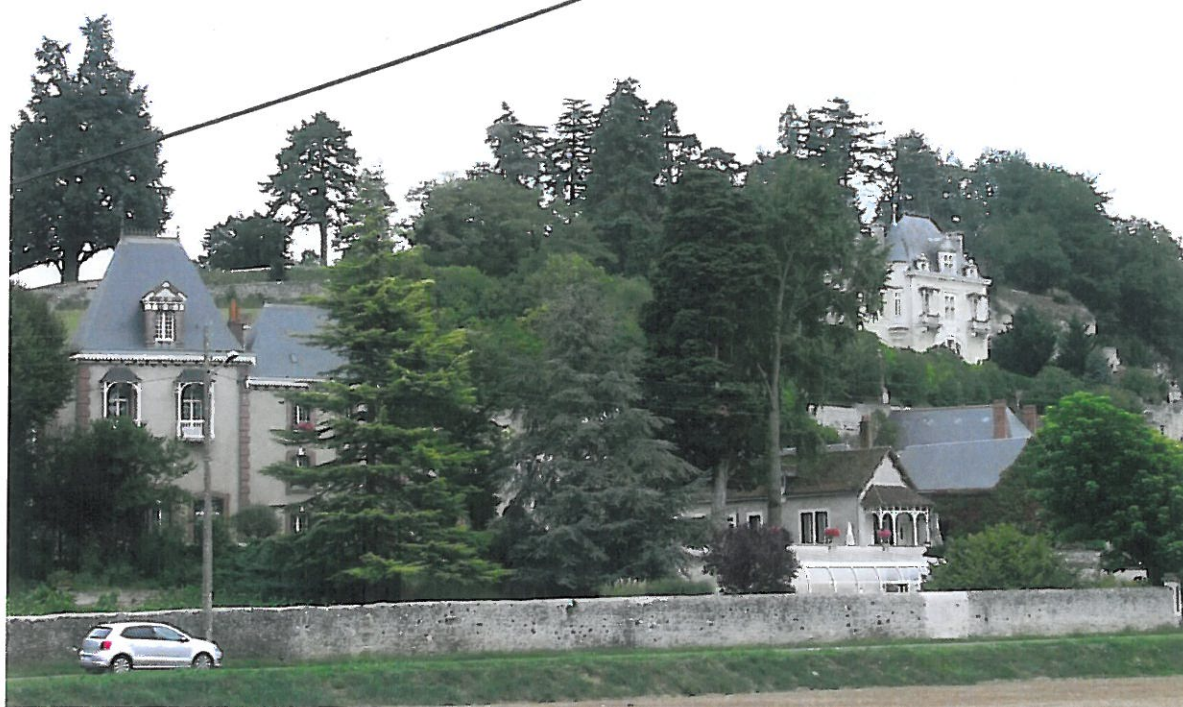
Vue sur les deux châteaux de la rue Debré depuis l'entrée sud du bourg
