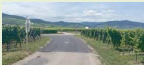
Réfection d'enrobés, ici sur le chemin Mattensteinweg , par l'entreprise TORREGROSSA
