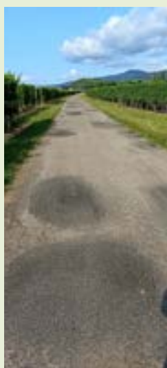
Rebouchage des nids de poule par blowpatcher, enrobé en spray, par l'entreprise EUROVIA
