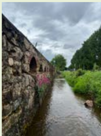
Nettoyage du muret du ruisseau, rue du Barrage
