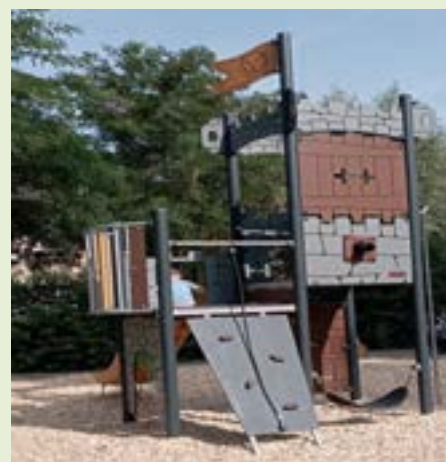
Remplacement de la structure de jeux et installation d'une balançoire, par l'entreprise NGE
