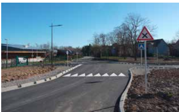
Reprise du niveau de la chaussée : Par l'entreprise Pontiggia - devant le 5 rue Pasteur
