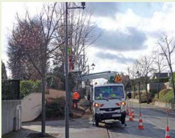
Elagage dans les rues et au niveau de la promenade le long de la Fecht
