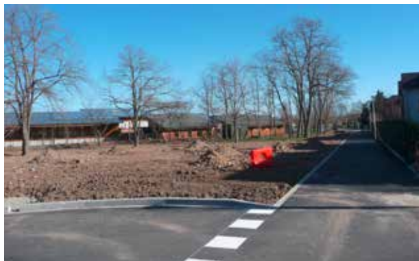
Aménagement d'un carrefour devant les Rives de la Fecht Par l'entreprise Pontiggia
