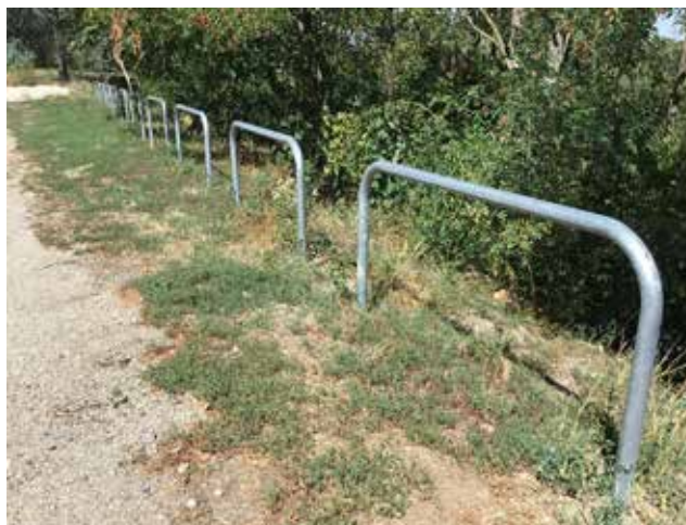
Mise en place d'arceaux de sécurité sur le parking côté plan d'eau
