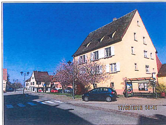
N°7, rue de la République, bâtiment en vis-à-vis du monument historique.
