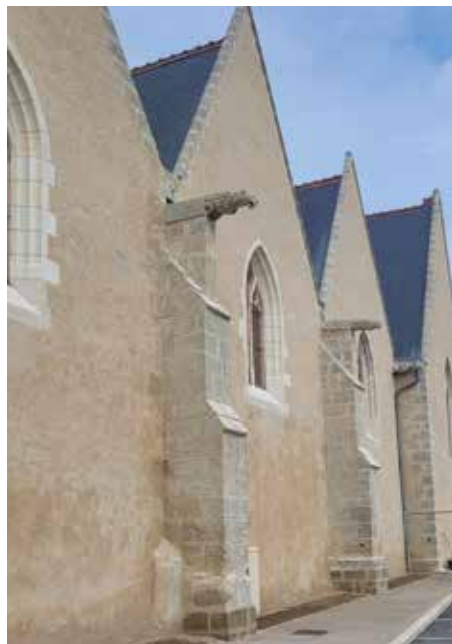
attribué par le Conseil Départemental d'Indre-et-Loire pour 69 744 € - Fondation du Patrimoine et l'association de Sauvegarde du Patrimoine pour 38 040 €
