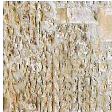
Façade pierre avec joint beurré
