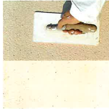
Enduit à la chaux frotté
