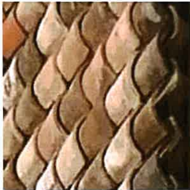
Couverture tuile canal
