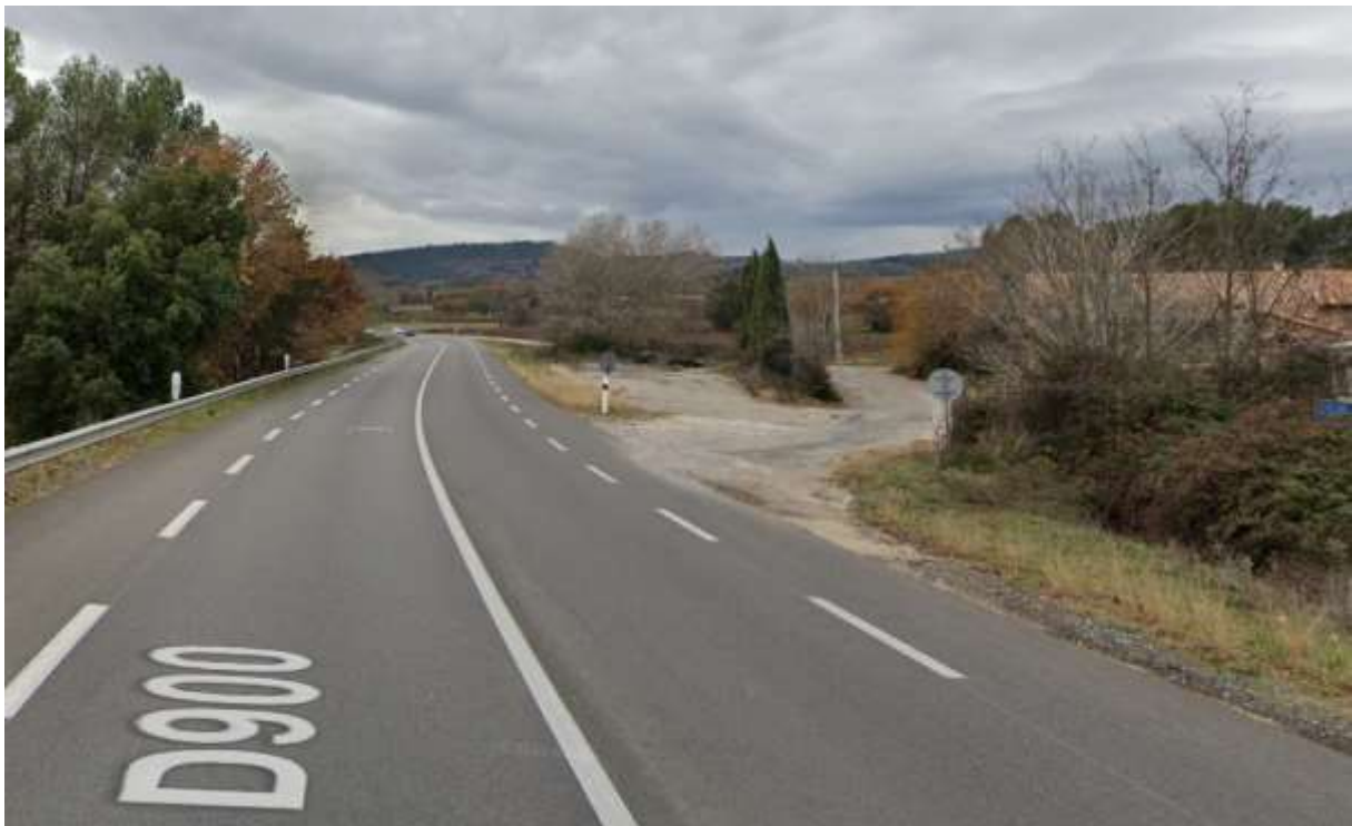
Accès sens Apt/Avignon - Source : Google Street View, décembre 2022
