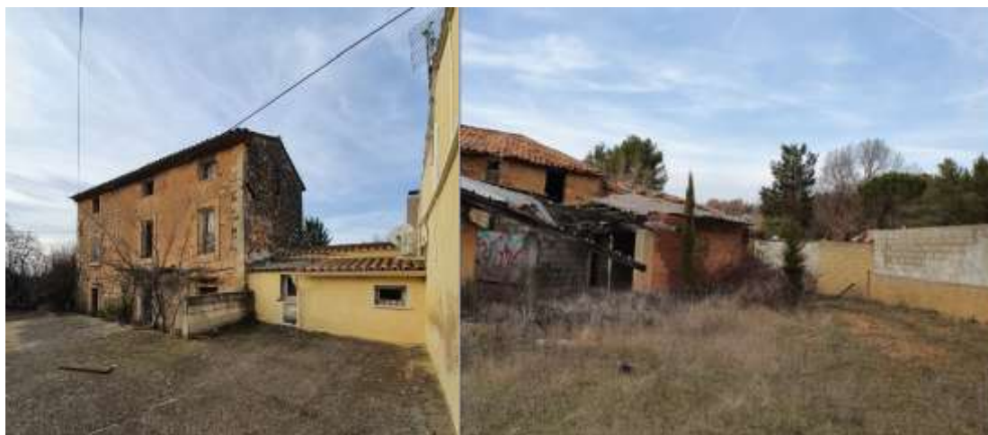
Clichés des anciens bâtiments de l'usine - Source : dossier de pièces graphiques – QD Développement (novembre 2022)
