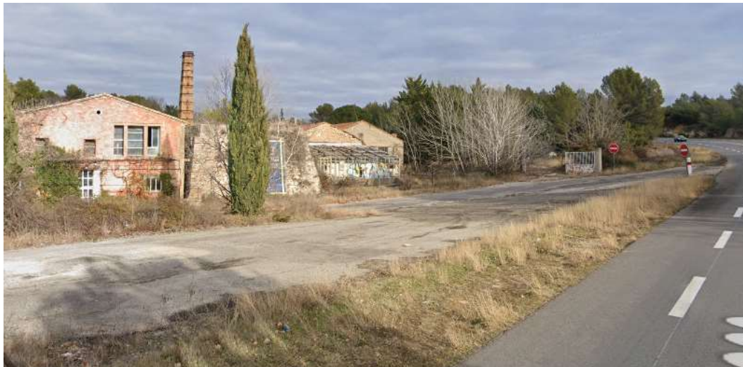
Entrée du site sens Apt/Avignon - Source : Google Street View, décembre 2022
