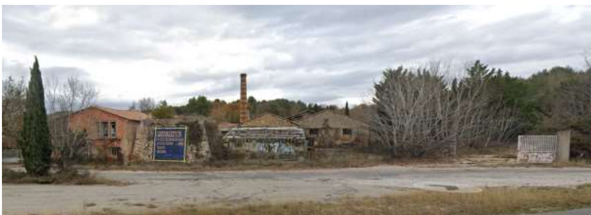
Vue frontale du site depuis la RD900 - Source : Google Street View, décembre 2022
