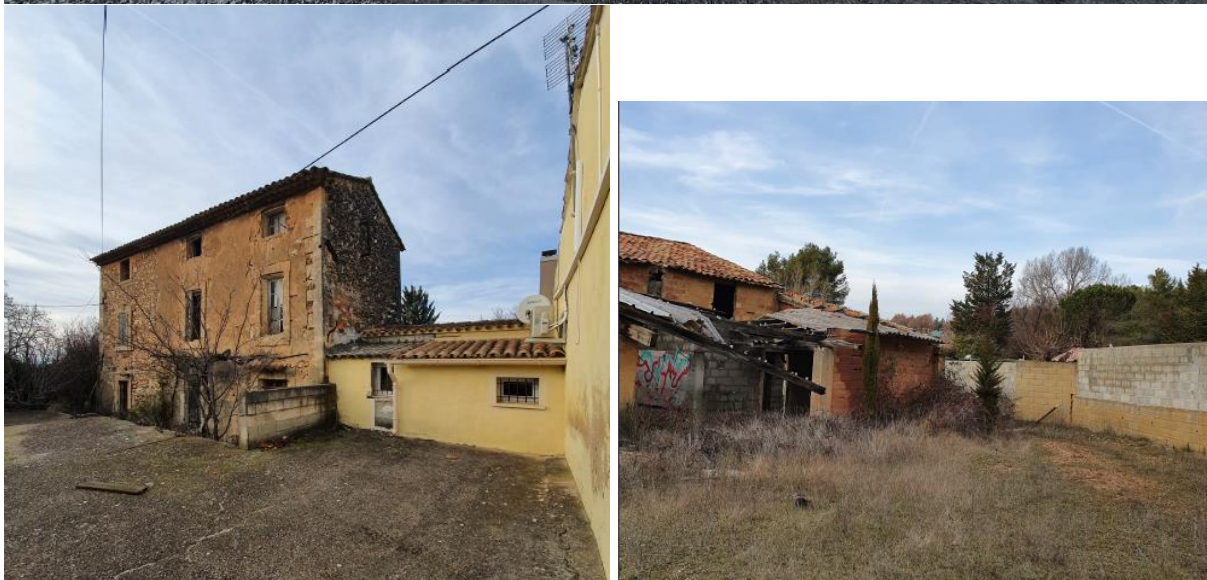
Clichés des anciens bâtiments de l'usine - Source : dossier de pièces graphiques – QD Développement (novembre 2022)
