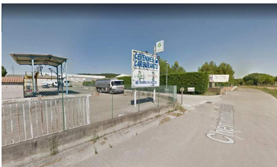
Vue du dépôt de carburant
