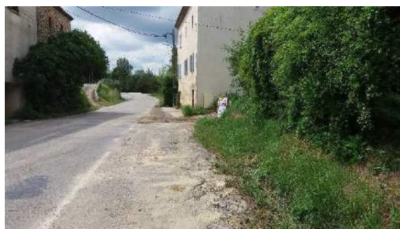
Vue de la D106 vers l'aval
