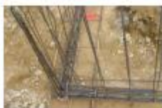
Nœud de chaînage - Continuité mécanique
