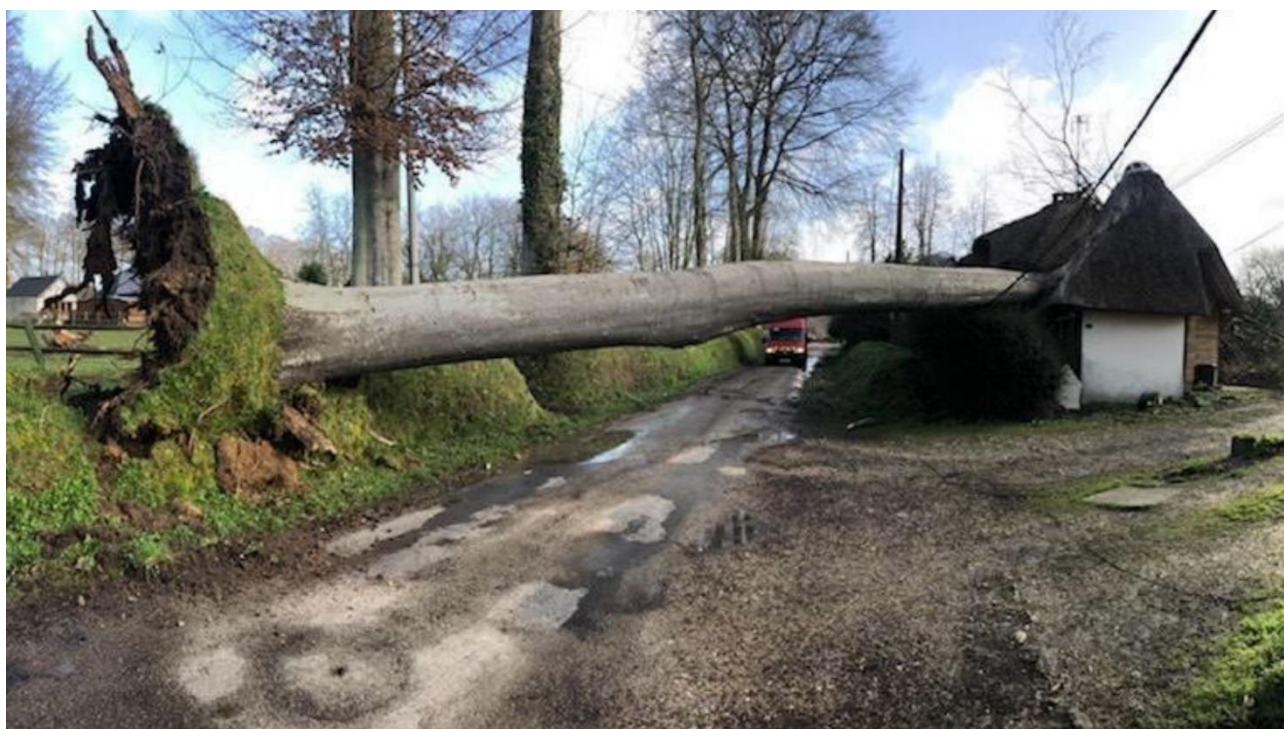
Mars 2019 : Chute d'arbre sur une chaumière à Ermenouville en Seine-Maritime
