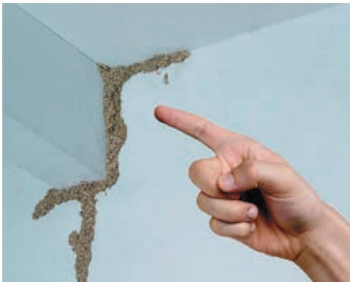
Les insectes xylophages, les termites en particulier, peuvent occasionner des dégâts importants en dégradant le bois et ses dérivés utilisés dans la construction du bâtiment. Ces insectes peuvent aussi dégrader la structure même du bâti et dans les cas les plus extrêmes, conduire à son effondrement.
