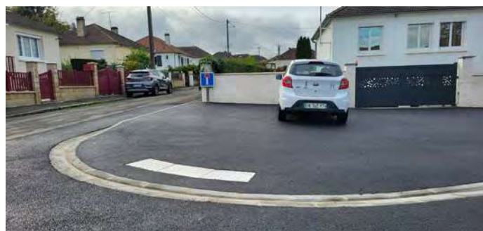
Travaux voirie - Rue Alphonse Daudet
