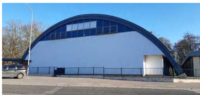
Réfection façade du Gymnase
