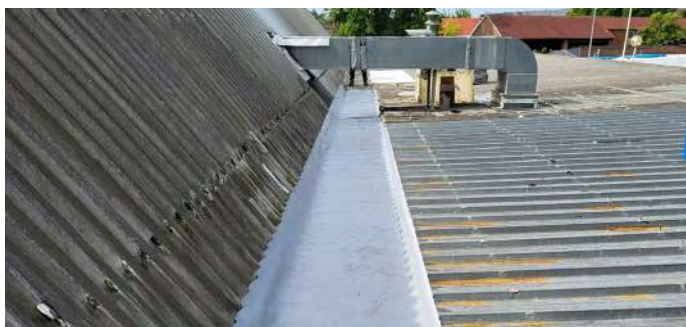
Réfection du chéneau Gymnase
