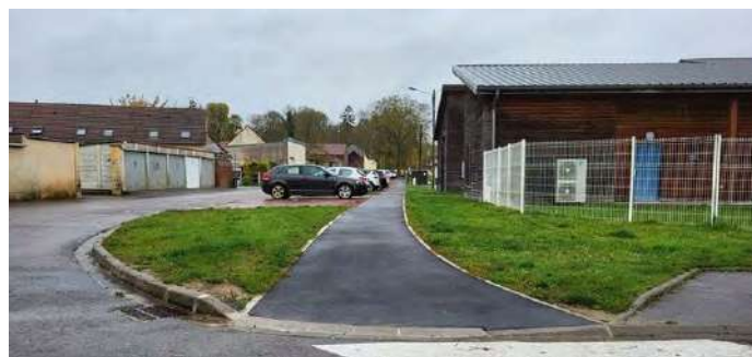
Passage piéton - Rue du Tour de Ville
