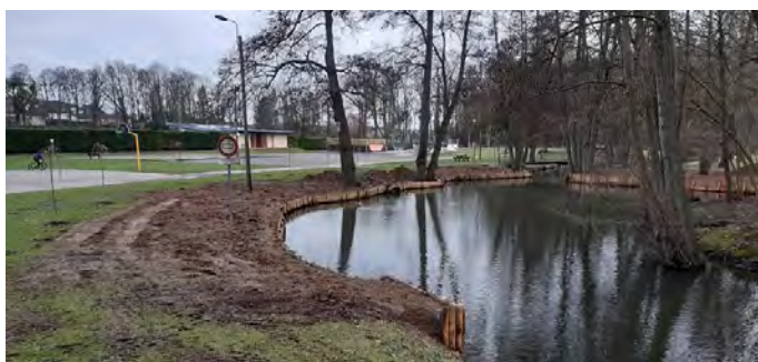
Poursuite du renforcement des berges
