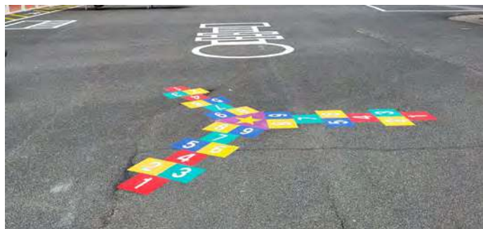
Remise en peinture jeux cour des écoles
