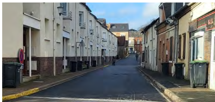
Travaux de voirie - Rue Mangin
