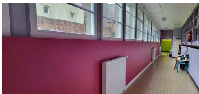
Réfection du couloir - École Bogaërt
