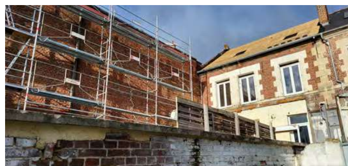
Entretien de la toiture du Cinéma
