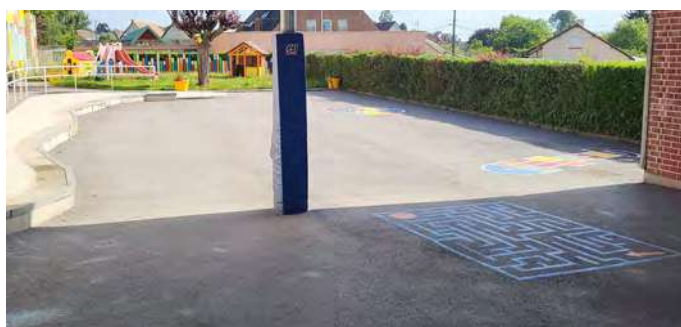
Remise en peinture jeux cour des écoles
