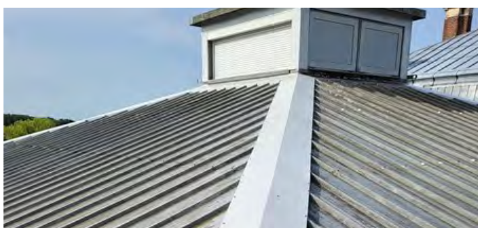
Travaux toiture de la salle des fêtes
