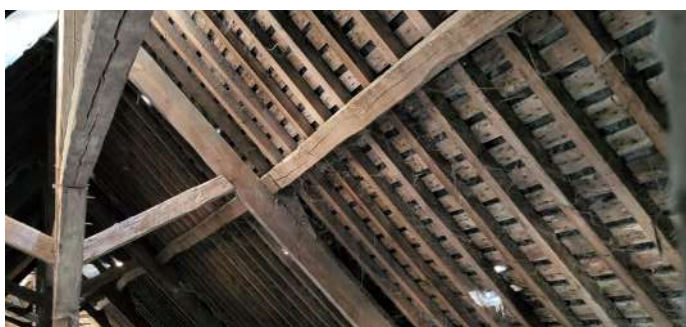
Travaux toiture de l'église
