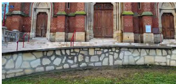
Réfection muret Monument aux Morts
