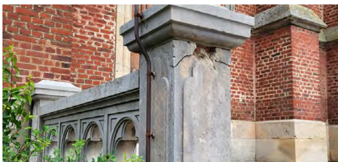
Réparation parvis de l'église
