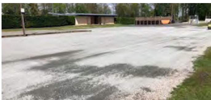
Réfection du terrain de pétanque
