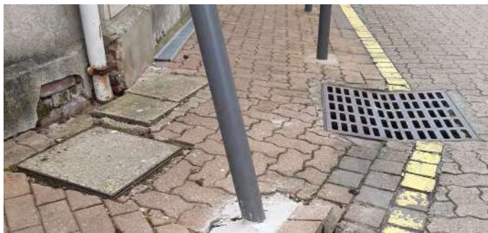
Remise en place de potelets
