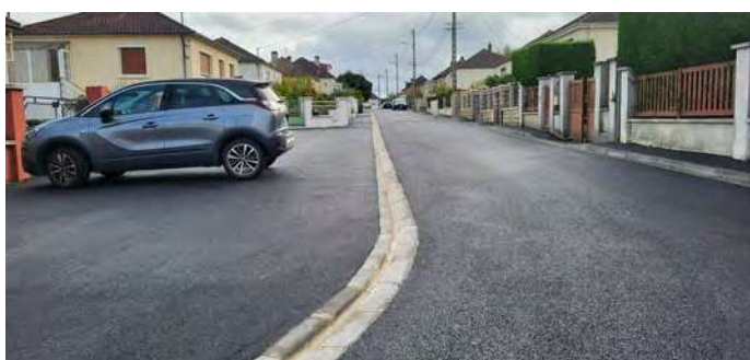
Travaux de voirie - Rue Alphonse Daudet
