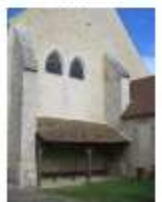
(4 bis) chevet avec ses deux fenestres en arc brisé
