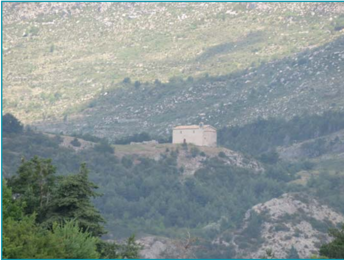
La chapelle originelle réhabilitée
