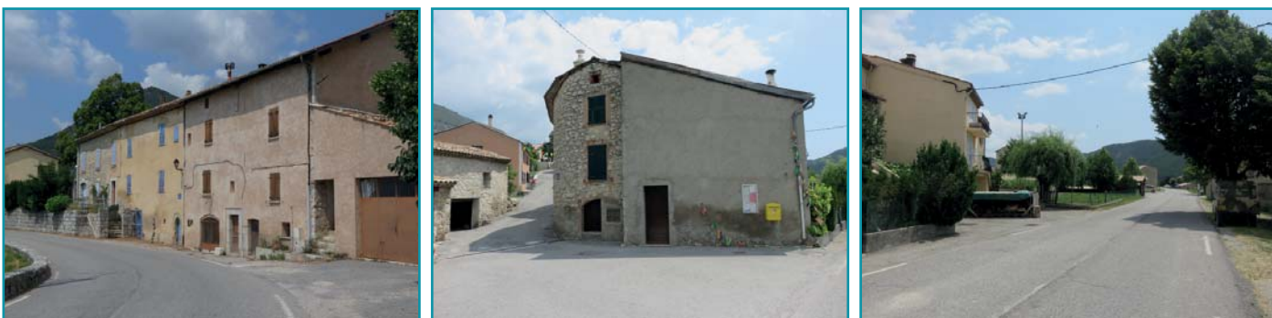
Absence de trottoirs le long de l'axe départemental RD 2211
