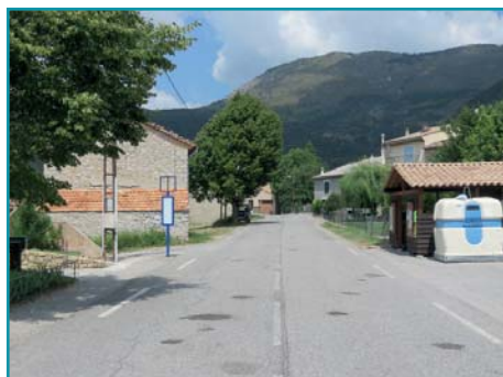
La RD 2211 au droit de la Foux
