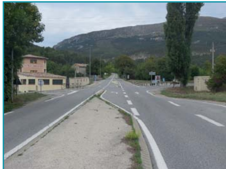
La RD 4085 au droit de la Bâtie
