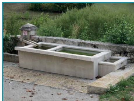
Lavoir sur La Bâtie
