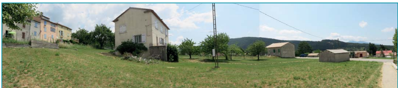
De vastes parcelles non bâties au sud du hameau, jusqu'à la RD 2211
