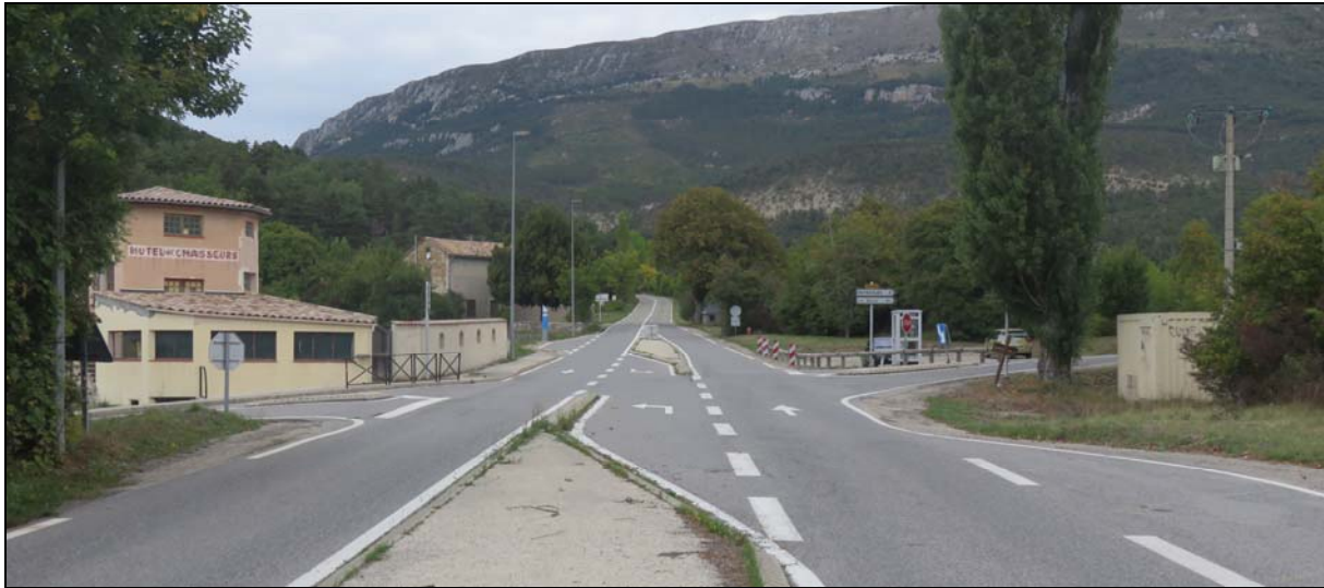
Figure 1 : Vue depuis la RD 4085 sur la partie Est du site objet de l'étude
