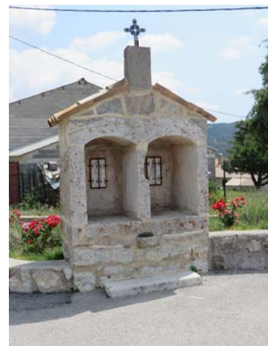
Oratoire, lieudit La Foux, rue des Tilleuls
