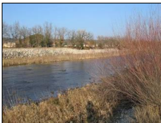
Protection de berge à Vinon-sur-Verdon
