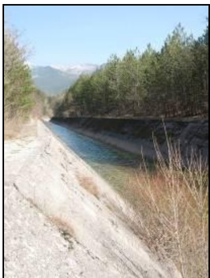
Canal de fuite de Chaudanne
