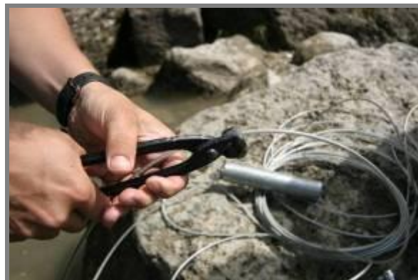
Installation d'un thermographe
