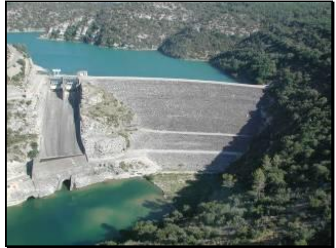
Le barrage de Gréoux
