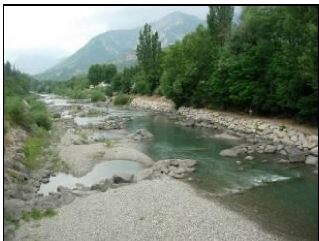
Protection de berge dans la traversée de Castellane
