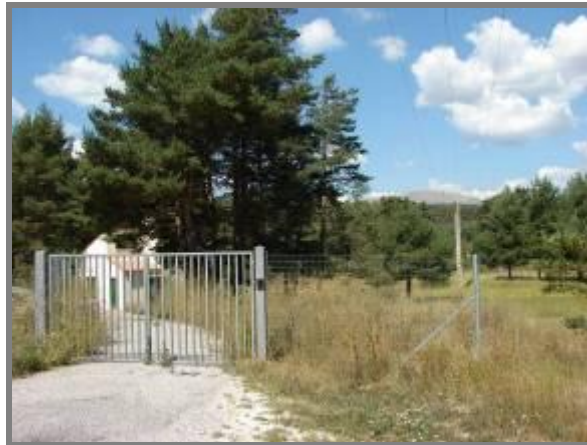
Captage d'eau potable
