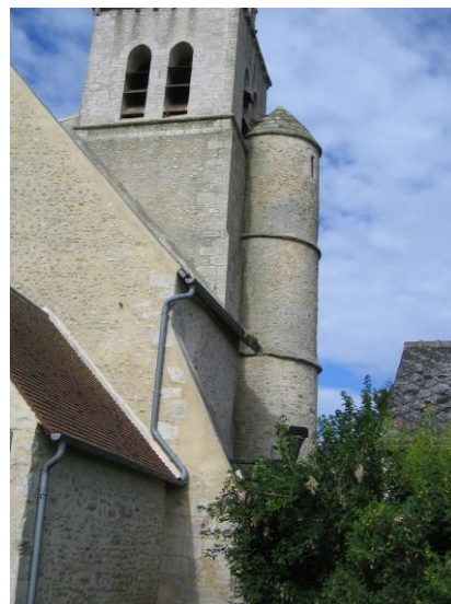
12 clocher et tourelle de l'escalier du clocher
