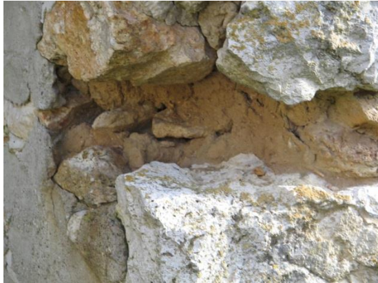
Appareil de silex, de terre et de grès pour construire un mur.
