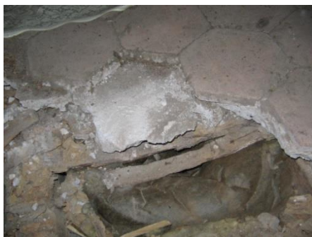
Tomette sur bauge et terre blanche compactée et lissée à la truelle (sol de grenier sur liteaux anciens (branches clouées sur lambourdes))
