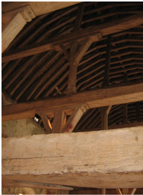
Charpente de l'Abbaye de Nottonville aux bois (Eure-et-Loir)
