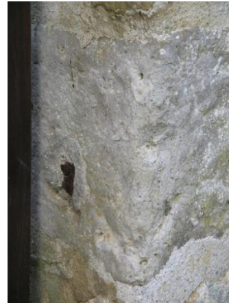
Appareil de silex, de terre et de grès pour construire un mur.
