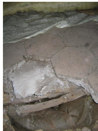
Tomette sur bauge et terre blanche compactée et lissée à la truelle (sol de grenier sur liteaux anciens (branches clouées sur lambourdes))
