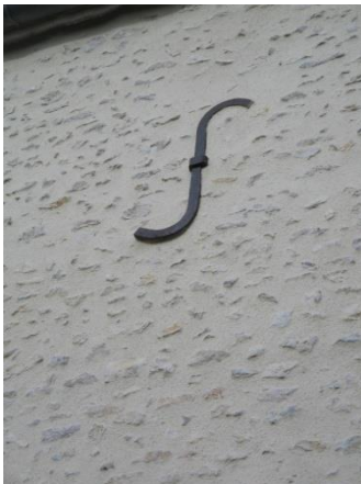
Tirants traditionnels avec anneaux et écrou de force.
