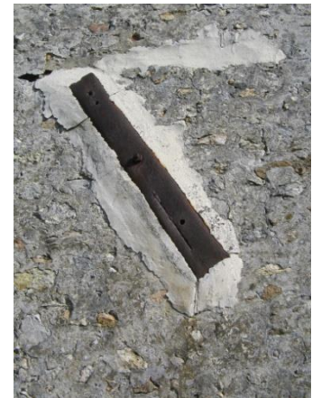
Tirants traditionnels avec anneaux et écrou de force.
