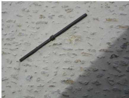
Tirants traditionnels avec anneaux et écrou de force.
