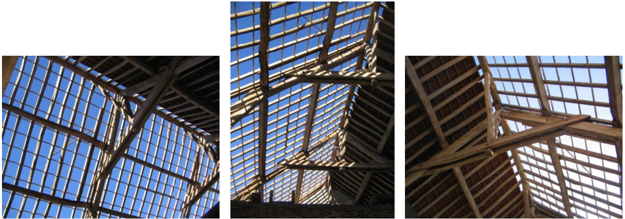
Charpente de grange en réfection
