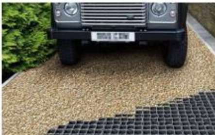
Structure nid d'abeille remplie de gravillons
