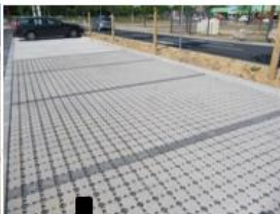
Pavés non jointifs joints sablés
