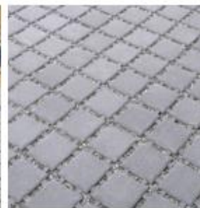
Pavés non jointifs joints sablés
