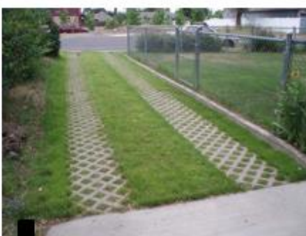
Structure béton alvéolé avec bande de roulement
