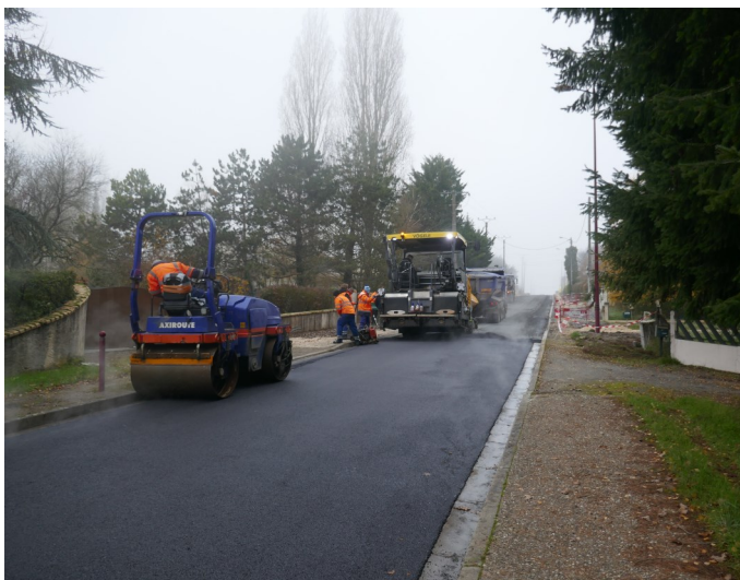
Page 8 Travaux voirie
