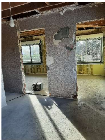
Ouvertures de la cloison cuisine sur la salle et d'un accès du garage vers le jardin
