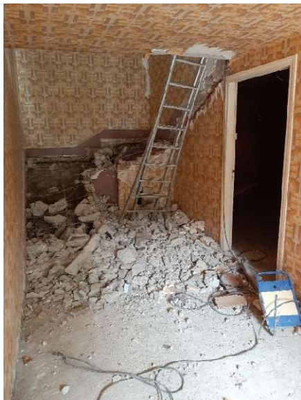
Démolition de l'escalier béton (accès rdc au 1 er étage)
