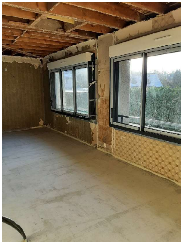
Pièce à vivre : nouvelle chape, avant pose de l'isolation et du placoplâtre
