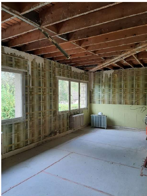
Pièce à vivre : nouvelle chape, avant pose de l'isolation et du placoplâtre
