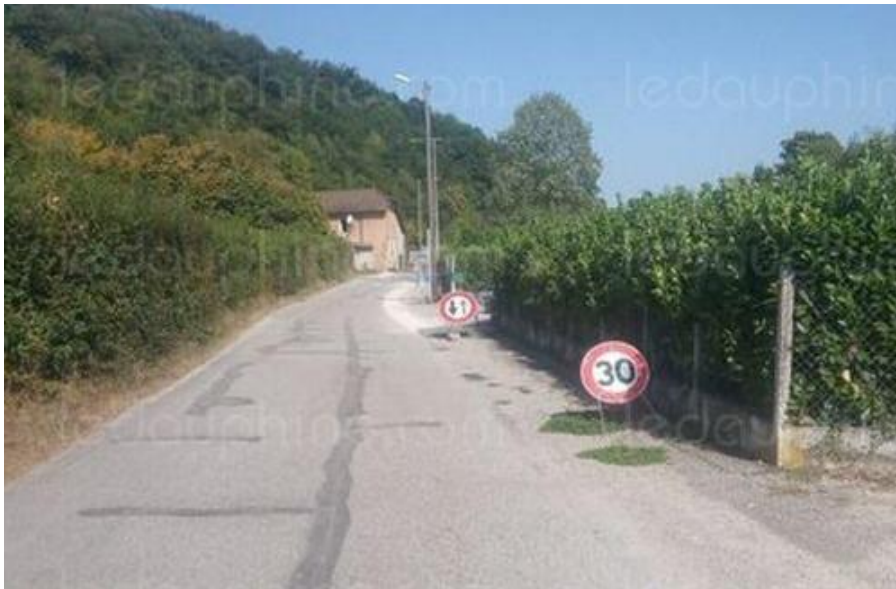
Les travaux de voirie rue Pénélon sont terminés.
