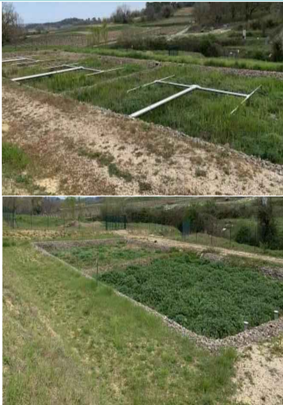
Illustration 4 : premier et deuxième étage de roseaux de la station d'épuration
