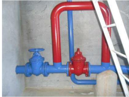
Figure 28 : Conduite de refoulement et conduite de distribution avec défense incendie
