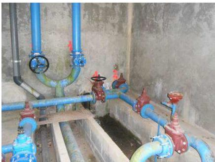
Figure 11 : Chambre des vannes
