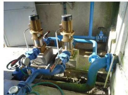
Figure 26 : Bâche de reprise - chambre des vannes
