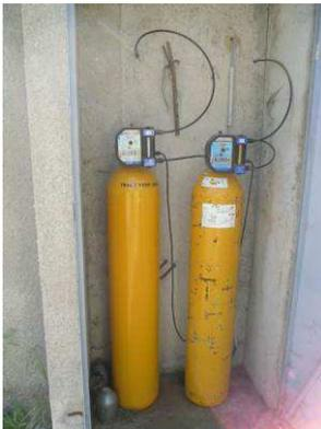
Figure 6 : Bouteilles de chlore
