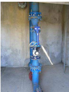
Figure 15 : Chambre des vannes - Conduite de distribution
