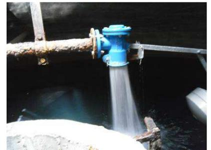
Figure 24 : Robinet flotteur surpressé
