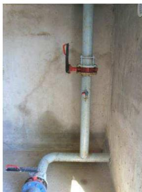
Figure 16 : Chambre des vannes - Conduite d'adduction
