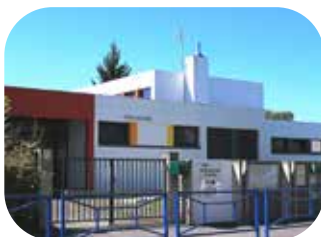
Bâtiment maternelle Impasse des Cèdres
