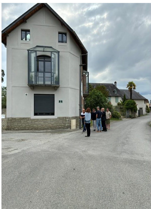
2 ème tranche de travaux d'enfouissement des réseaux
