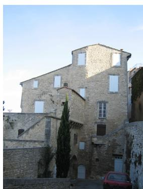
Le Portalet est une porte intérieure au rempart nord du XIV<sup>e</sup> s. ; elle est constituée de deux travées de voûtes d'arêtes de 9m d'épaisseur, surmontée d'une salle de garde également voûtée et couronnée par une coursière étroite, plus récente, en encorbellement sur six consoles.
