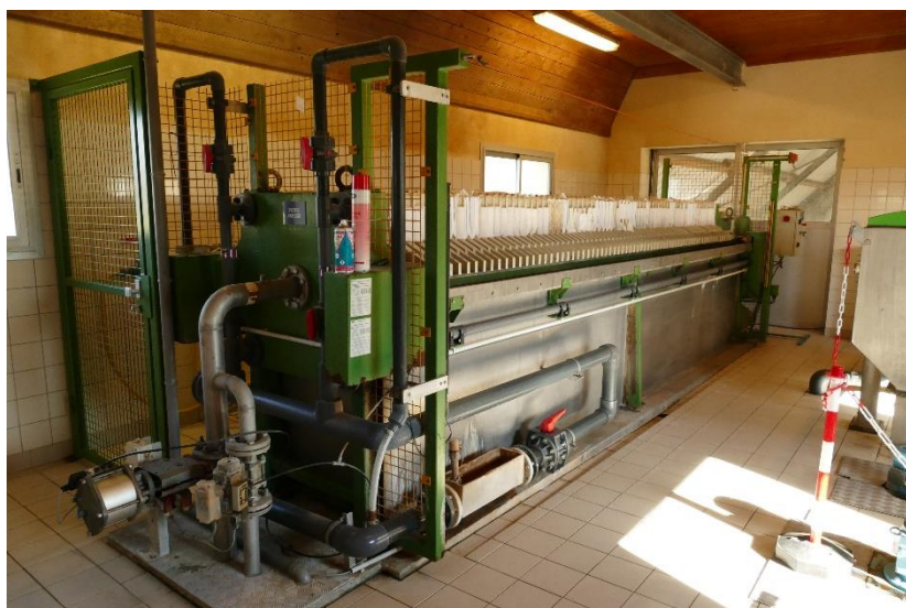
Filtre-presse à plateaux (72 plateaux 800x800 mm)
