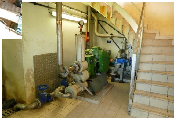
Pompe à piston/membrane pour le remplissage du filtre-presse
