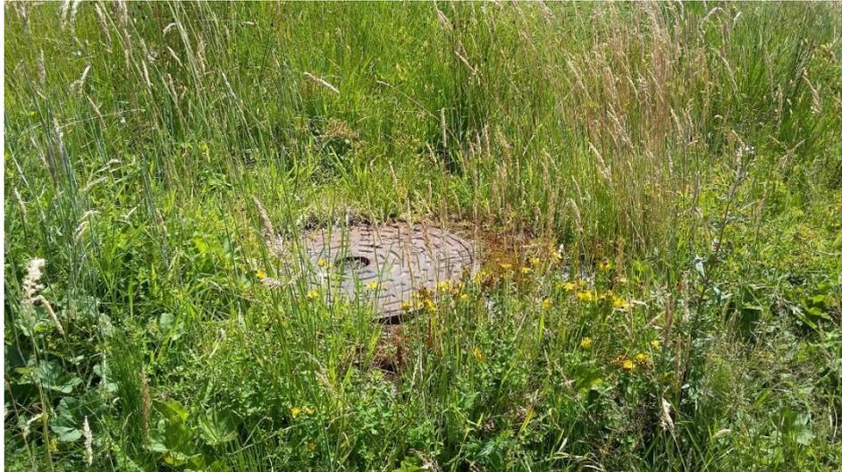
*Photo 15 : un regard du réseau eaux usées traversant la zone humide amont (Cimeo 13/07/2023)*
