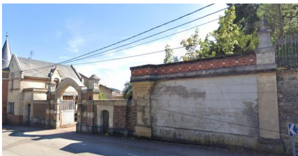
Vue sur l'accès existant et le mur surmonté d'une frise
