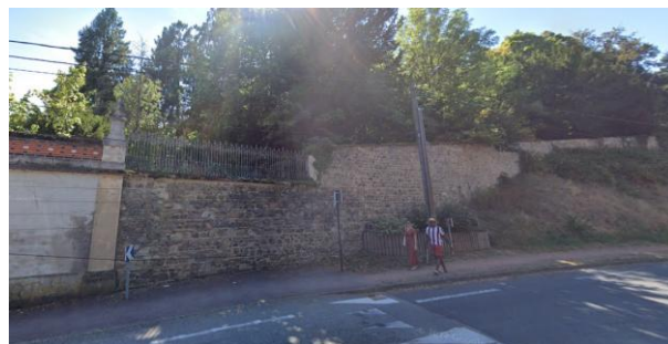
Vue sur le mur « de soutènement ».
