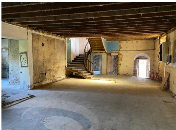
**Le projet de rénovation de l'Hôtel Provost se poursuit.** Durant l'été, les travaux de curage, c'est-à-dire le retrait de l'ensemble du second œuvre et des structures non porteuses, ont été effectués.
