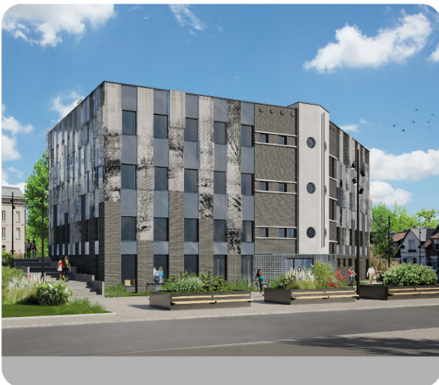
Centre de formation UPJV - vue rue de la Croix Saint-Claude
