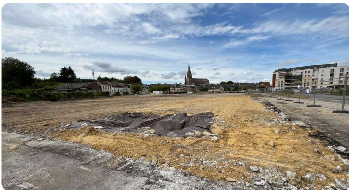
Avancement chantier_finalisation remblais
