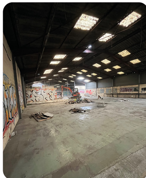
Avancement du chantier intérieur
