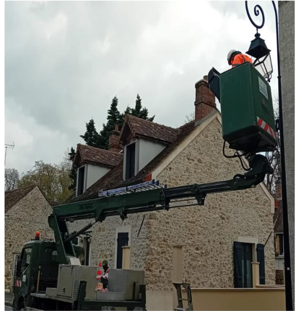
Lors du passage, les techniciens allument les candélabres afin de détecter d'éventuels dysfonctionnements. Cette inspection permet d'identifier les lampes défectueuses ou les éventuels problèmes électriques.
