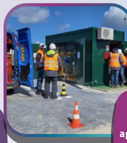
Chantier de maillage de Bollezelee à Cappelle-Brouck 14 février 2023
