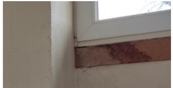
État des lieux avant intervention : murs marqués par l'humidité
