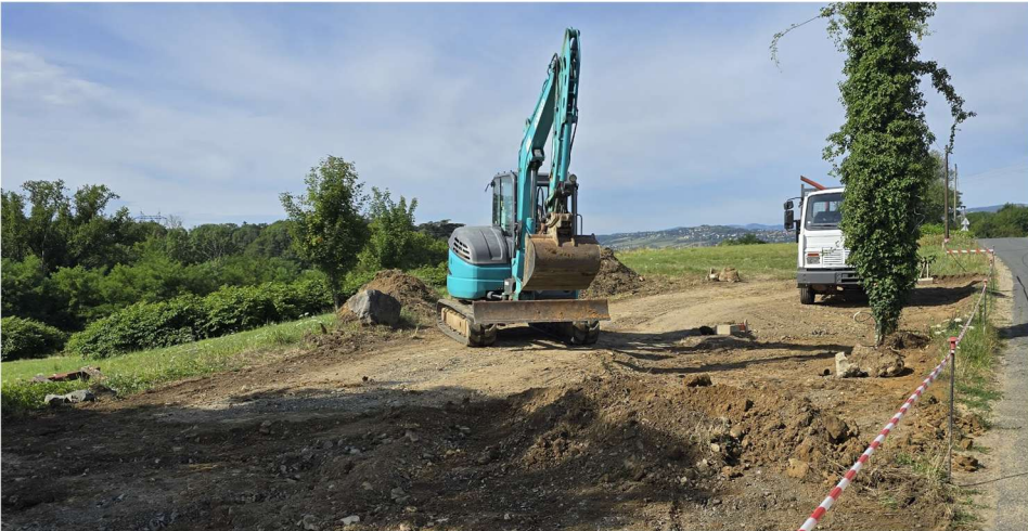
Le chantier du parking, le 23 Juillet 2025
