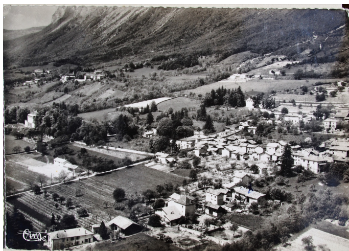
La Gravelière et la nouvelle école, 1956 (A&P)
