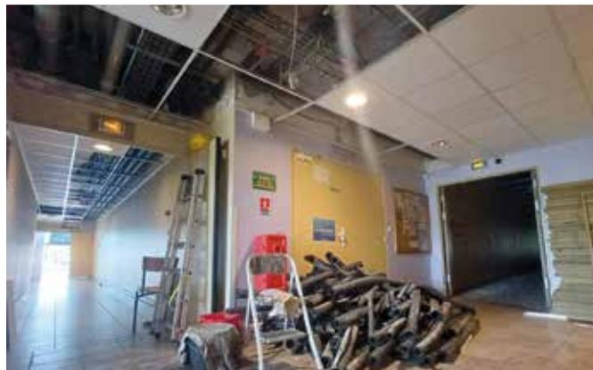
Dépose des faux plafonds couvrant les systèmes de chauffage et de production d'eau chaude sanitaire
