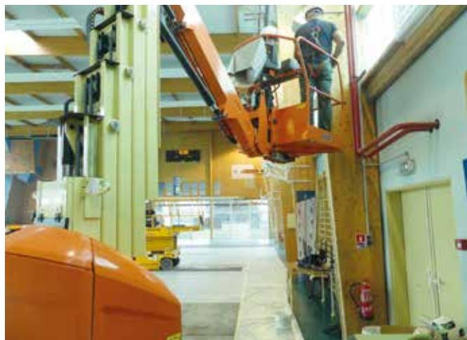
Dépose de 1,3 km linéaire de réseau de chauffage
