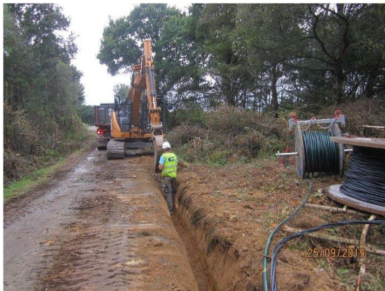
Figure 1 - Tranchées de câbles électriques à la pelle mécanique
