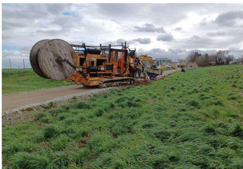
Figure 2 - Tranchée en bordure de chemin pour raccordement à l'aide d'une trancheuse
