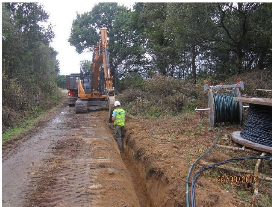
Figure 1 - Tranchées de câbles électriques à la pelle mécanique
