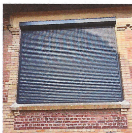
Pose de volets roulants aux écoles (=isolation+sécurité)
