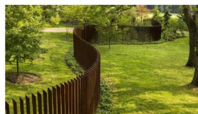
Clôture en acier corten posé verticalement – Archer & Buchanan Architecture
