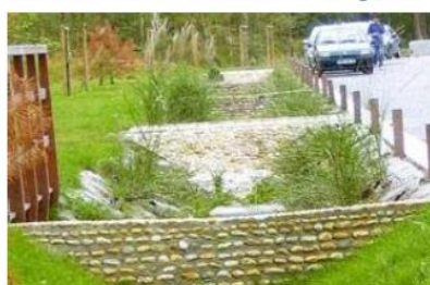
Noue paysagère, pour la rétention et l'infiltration des eaux pluviales à Douai (59)
