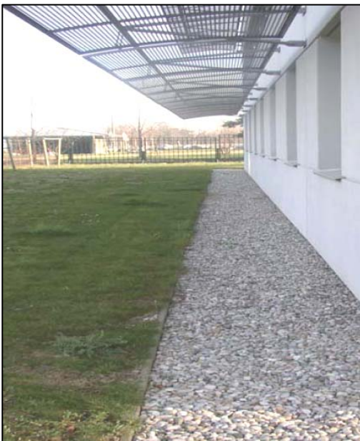
► Tranchées sous toit
