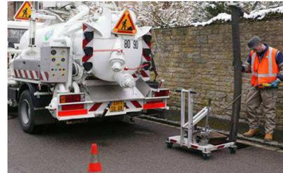
Le **curage curatif** des réseaux d'assainissement est réalisé afin de rétablir l'écoulement des effluents qui sont stoppés par des dépôts de matériau (terre, sable, cailloux), des objets (ballon, ...) en libérant le passage réduit de la section d'écoulement.
